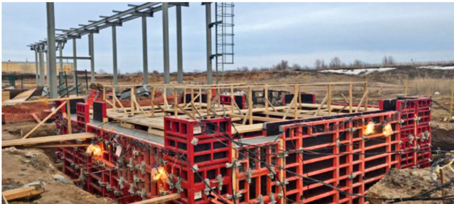
ООО «ТОМЕТ» г. Тольятти Пункт налива метанола. Строительство подземного резервуара.
