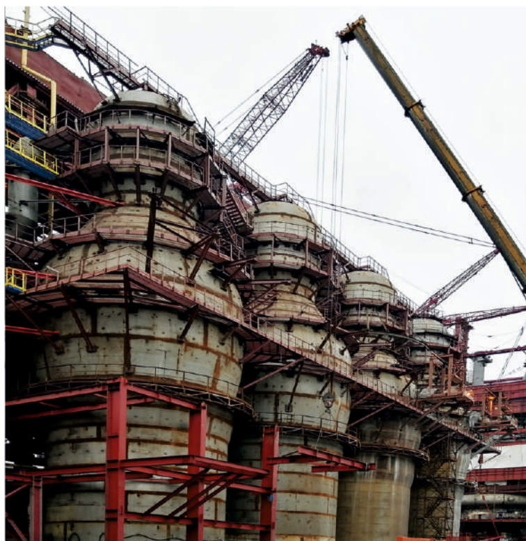
ПАО «Северсталь». КАДП Комплекс доменной печи №3. Блок воздухонагревателей. Обслуживающие площадки ВН 7-10
