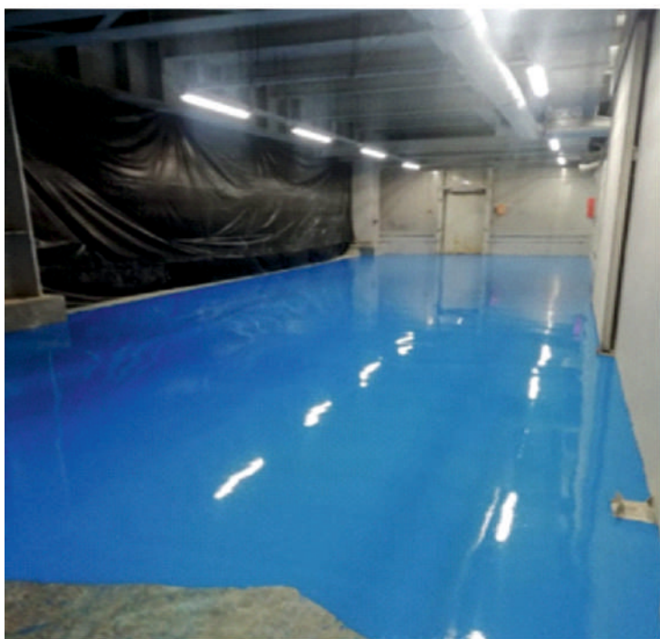
ООО «ЕвроХим-ВолгаКалий». Устройство полимерных наливных полов.
