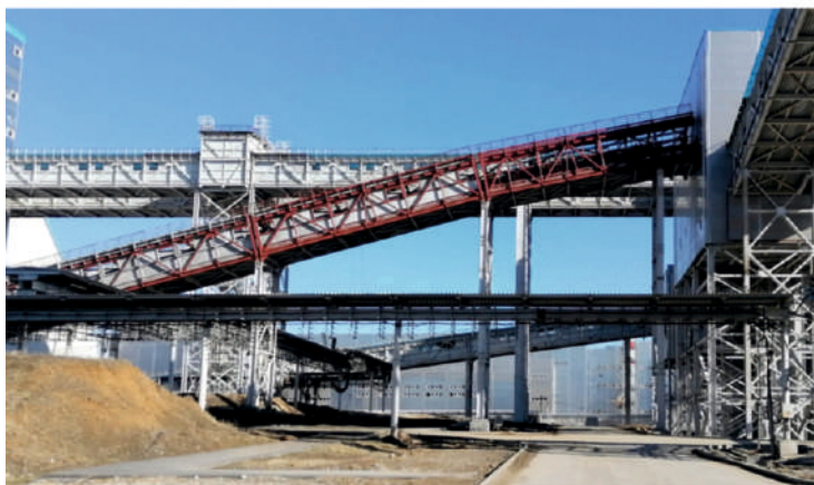
ООО «ЕвроХим-ВолгаКалий». Горно-обогатительный комбинат по добыче и обогащению калийных солей. Монтаж оборудования и АКЗ металлоконструкций.
