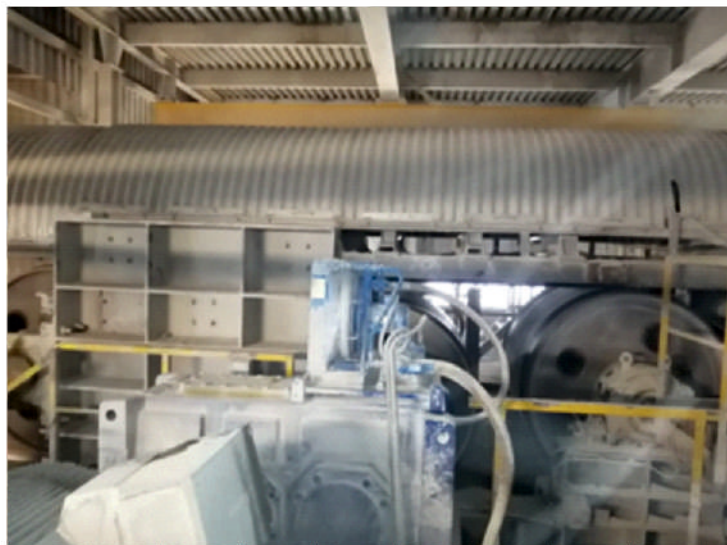
ООО «ЕвроХим-ВолгаКалий» монтаж конвейера подачи готового продукта. Устройство ограждающих конструкций и АКЗ.
