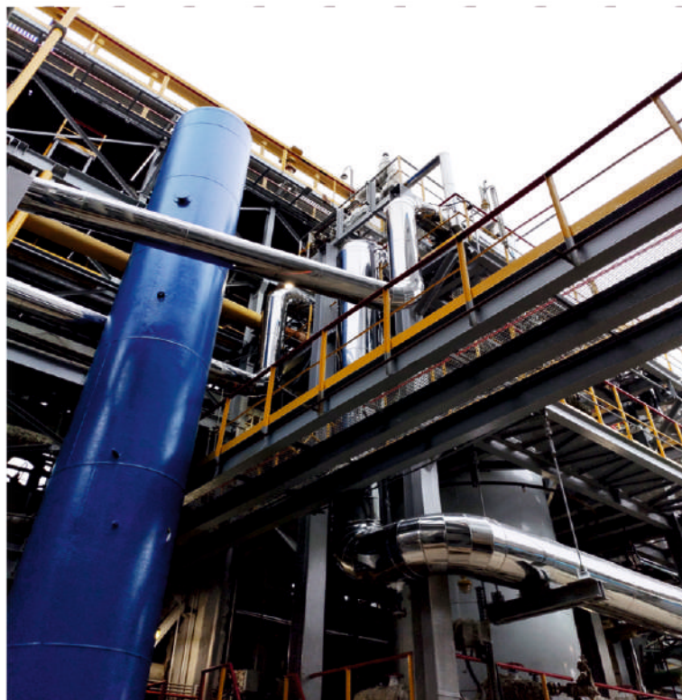
ПАО «Дорогобуж». Техническое перевооружение агрегата аммиака с увеличением мощности до 2100 тонн в сутки. TI трубопроводов.
