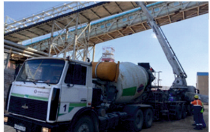
ООО «ЕвроХим-ВолгаКалий» г. Котельниково Устройство жб полов на конвейерной галерее
