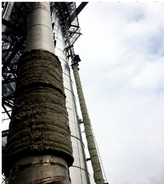
ПАО «Акрон» Строительство цеха АМ-4 Теплоизоляция методами промальпинизма.
