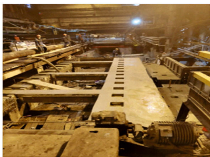
ПАО «Северсталь». Модернизация холодильников стана 2800 и линии резки.
