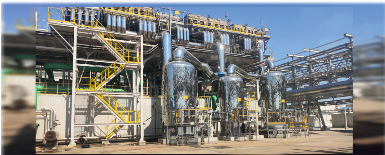
ПАО «Акрон» Выполнение комплекса теплоизоляционных работ
