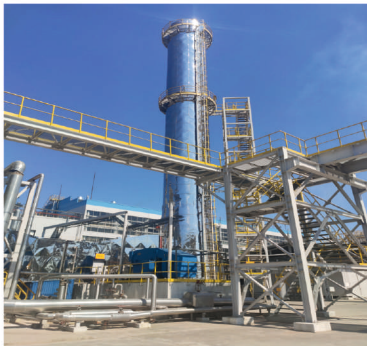
ПАО «Акрон» Выполнение комплекса теплоизоляционных работ
