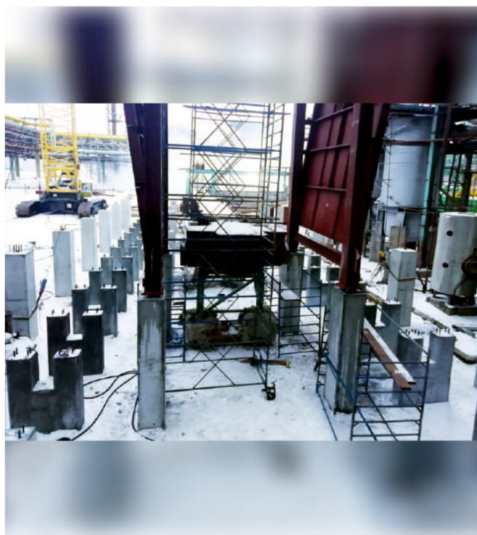
ПАО «ТОАЗ». Техпереворужение печи первичной конверсии метана Д-101. Устройство фундаментов.
