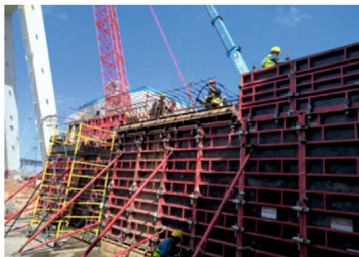
ООО «ЕвроХим-ВолгаКалий» г. Котельниково Монтаж железобетонных конструкций калориферного канала №2
