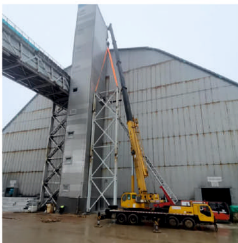
ООО ЕвроХим-ВолгаКалий г. Котельниково. Монтаж металлоконструкции галереи тракта подачи руды
