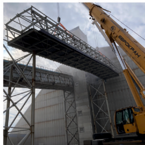
ООО ЕвроХим-ВолгаКалий г. Котельниково. Монтаж металлоконструкции галереи тракта подачи руды
